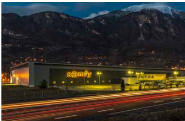
L'usine Somfy au bord de l'autoroute blanche à Bonneville
