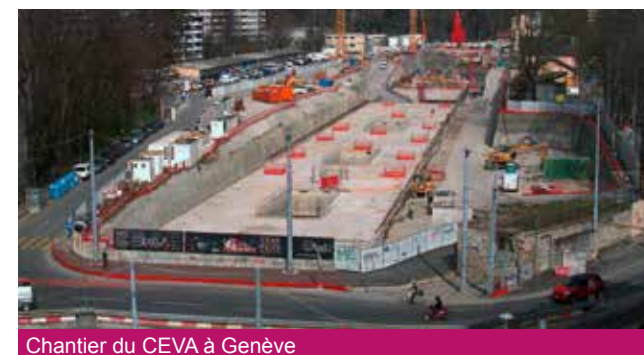
Chantier du CEVA à Genève
