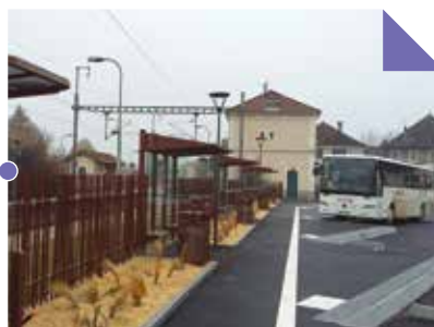
→ Aménagements gare Bonneville
